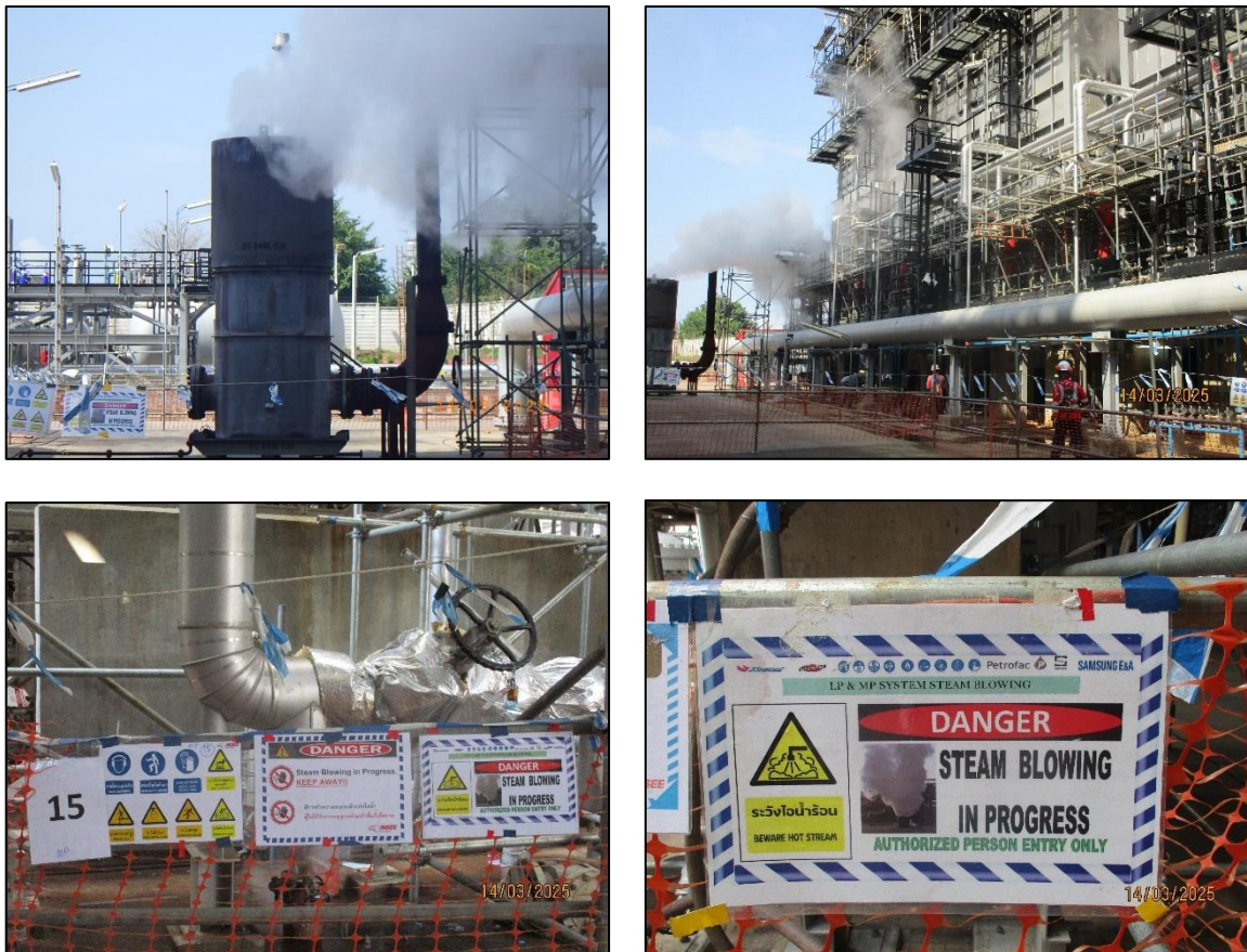
รูปที่ 1-2 งาน Steam Blowing
