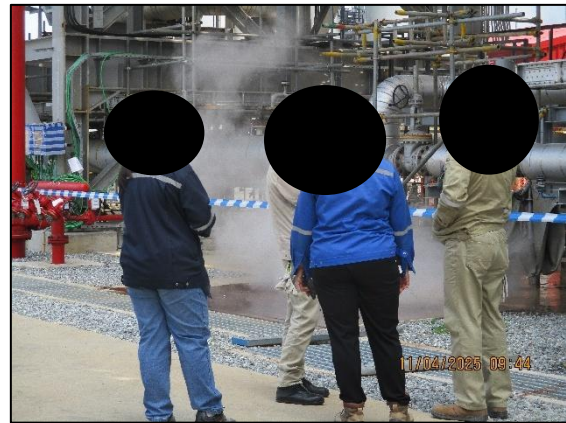
รูปที่ 1-2 งาน Steam Blowing
