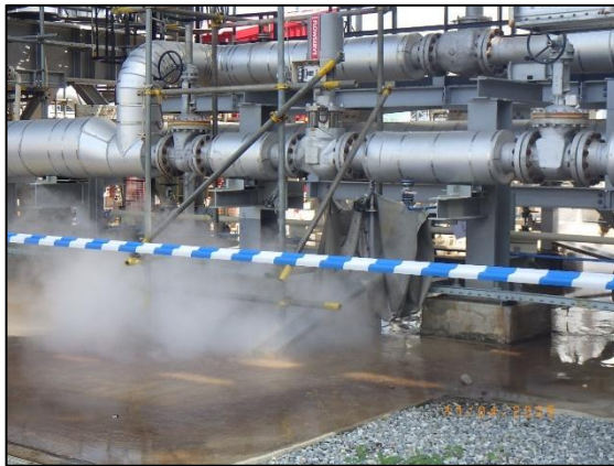
รูปที่ 1-2 งาน Steam Blowing
